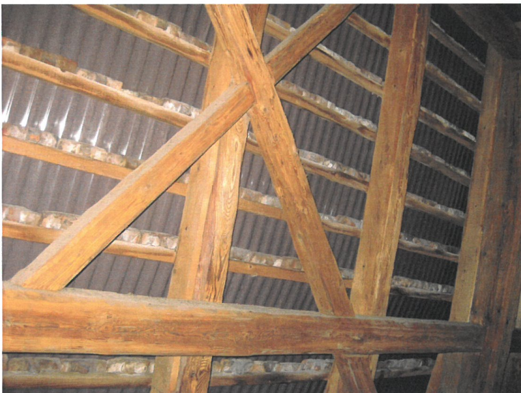
Dach mit Windaussteifung.
